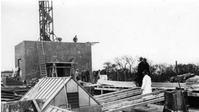
Abbildung 6 - Bau des Uhrenturms am Funkhaus Rothenbaumchaussee (1930).
